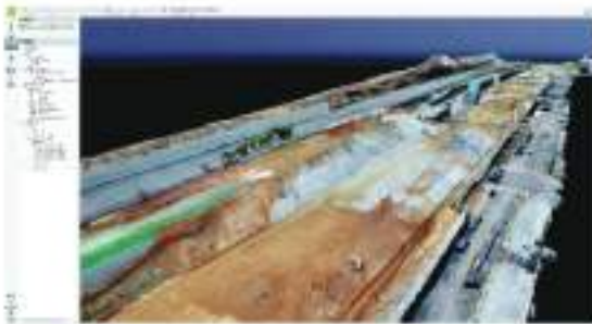
① 한국도로공사 - 경부동탄 직선화 1,2공구 현장
